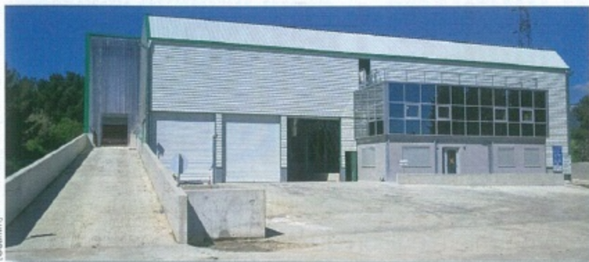
La centrale Latarge de la Seyne-sur-Mer.
