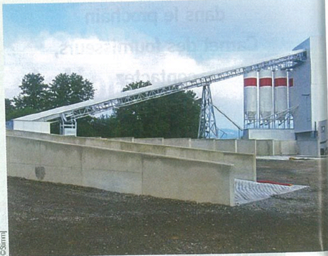
La centrale de Béton + à Montbrison.
